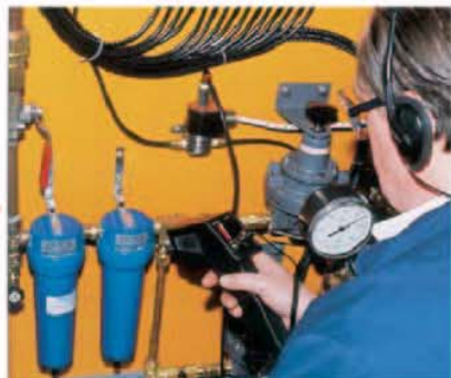
Inspección de sistemas neumáticos
