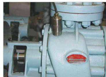
Monitorización de cavitación, rodamientos y válvulas
