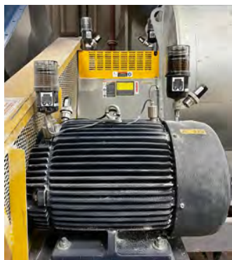
Solution de surveillance et lubrification autonome par Ultrasons : Ontrak - UESystems
