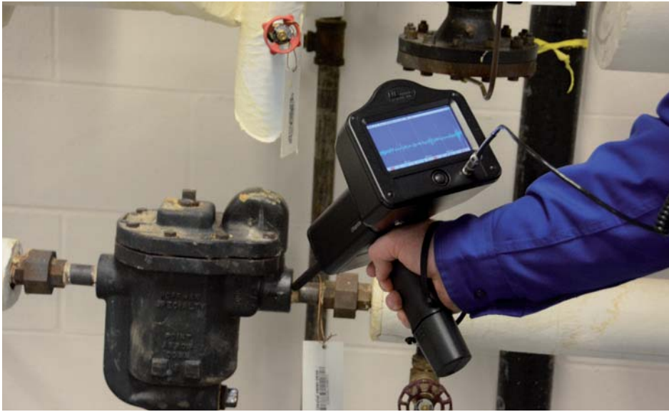
Figura 3. Um instrumento ultrassônico é uma ótima ferramenta para inspecionar purgadores de vapor.
