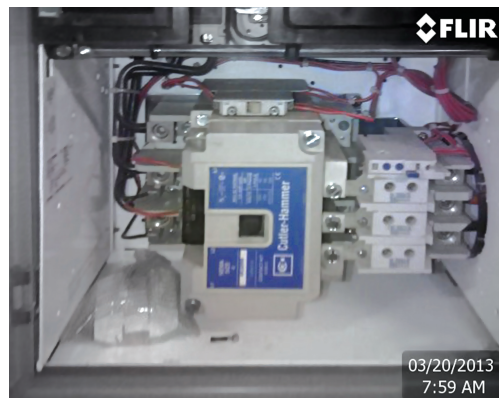
■ Vizualizarea Time Wave Form a ultrasunetelor înregistrate ale acestui contactor prezintă semne distincte de străpungere severă și stadii incipiente ale arcului.
