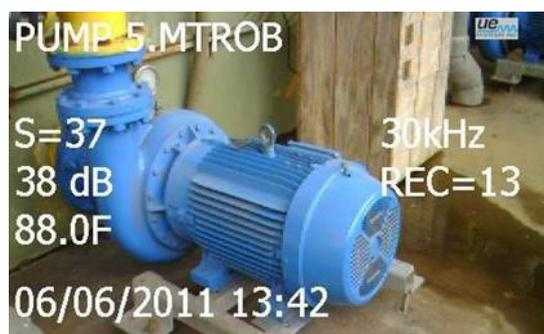
(<https://num1.elementsindustriels.fr/wp-content/uploads/2018/09/Unknown-4-1.jpeg>)L'image ci-contre a été prise par un instrument à Ultrasons lors de la collecte de données. Il s'agit d'une mesure ultrasonore sur un moteur de pompe. On note les paramètres et valeurs des mesures effectuées sur la photo elle-même. L'installation compte dans ce cas huit pompes identiques.
