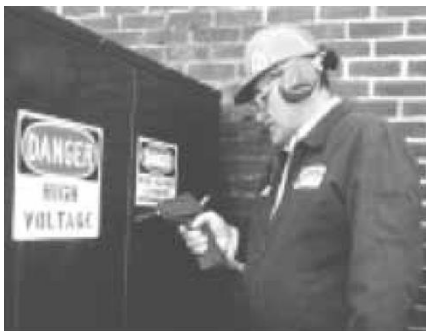
Überprüfung von Schaltanlagen, Transformatoren u.a. auf Lichtbögen, Korona und Kriechströmung
