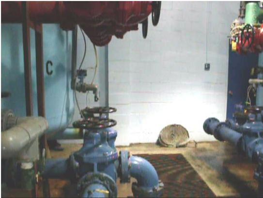
Escanee en todas direcciones en las áreas donde se sospeche que hay fugas. Cuando sea difícil determinar la dirección del ultrasonido generado por la fuga, suba la sensibilidad si el nivel sonoro es muy bajo o bájela cuando sea muy alto. Será más fácil localizar la fuga si se escanea completamente alrededor del área de interés.
