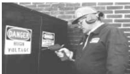
Inspeccione paneles de conmutación, transformadores etc. Para: arco, seguimiento y corona.
