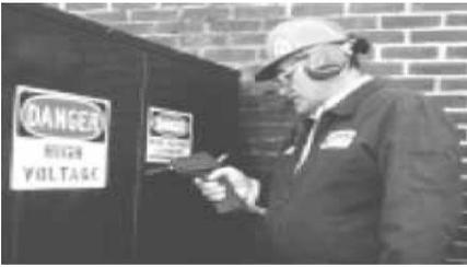
*Проверка выключателей, трансформаторов и т.д. на наличие электрической дуги, пробоя и короны.*
