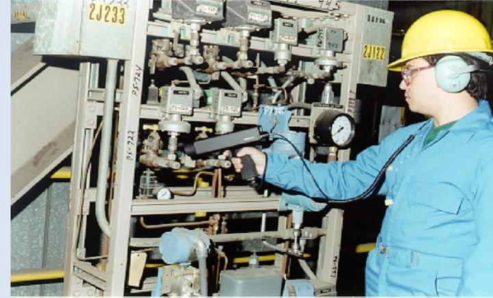
*Une méthode alternative de détection de fuite est l'utilisation d'un générateur à ultrasons*
